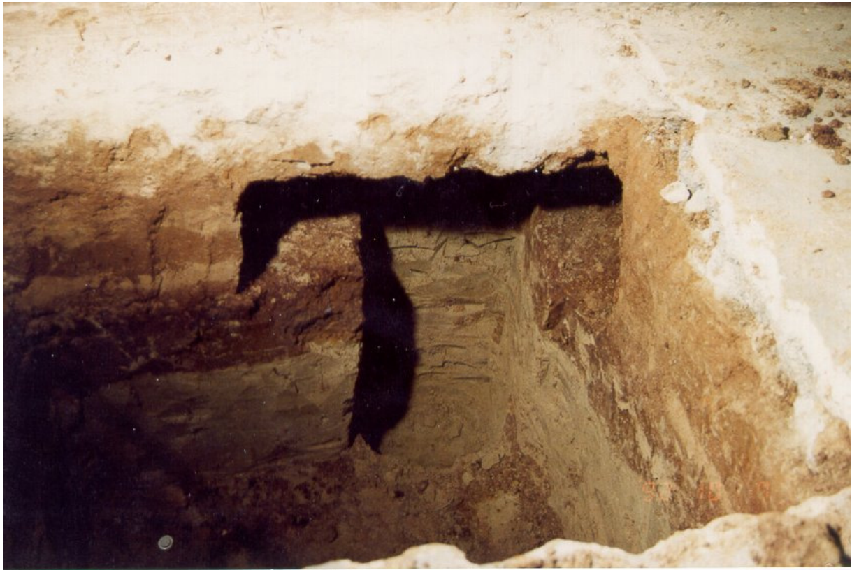
Bild 1: Fertiggestellte Kopfbaugrube mit Aussparung zur Aufnahme des Lastverteilungsbalkens
