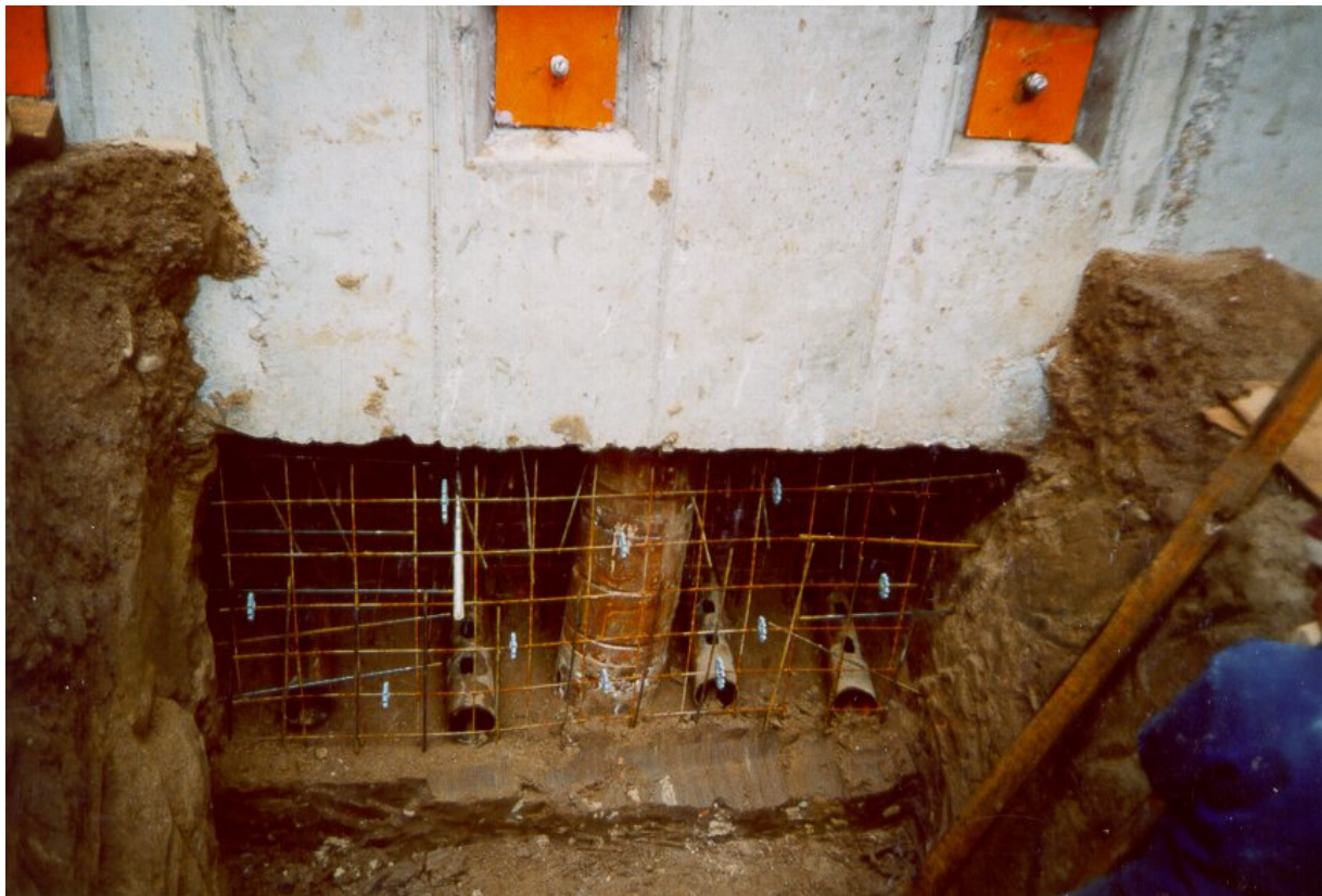
Bild 9: Unterfangungsabschnitt im Schutze eines Erka Pfahles
