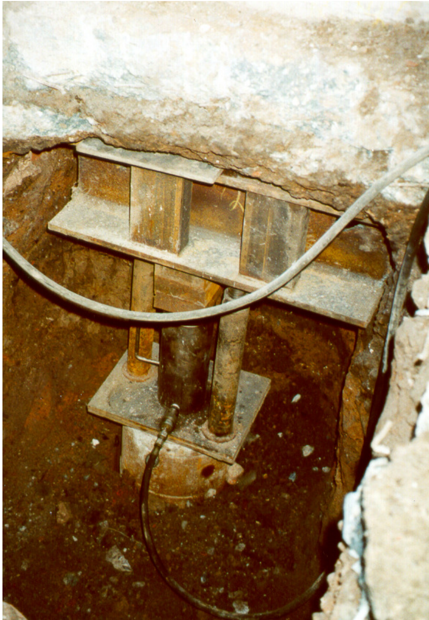
Bild 2: Widerlager, hydraulische Presse, Kopfplatte und Pfahlsegment
