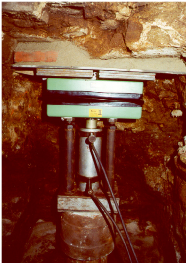
Bild 8: Federelement auf Erka Pfahl
