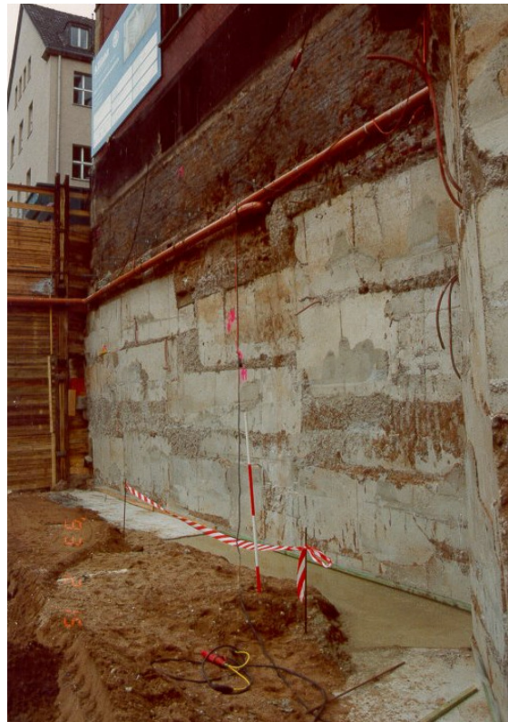
Abbildung 7: Ansicht einer fertigen Unterfangungswand
