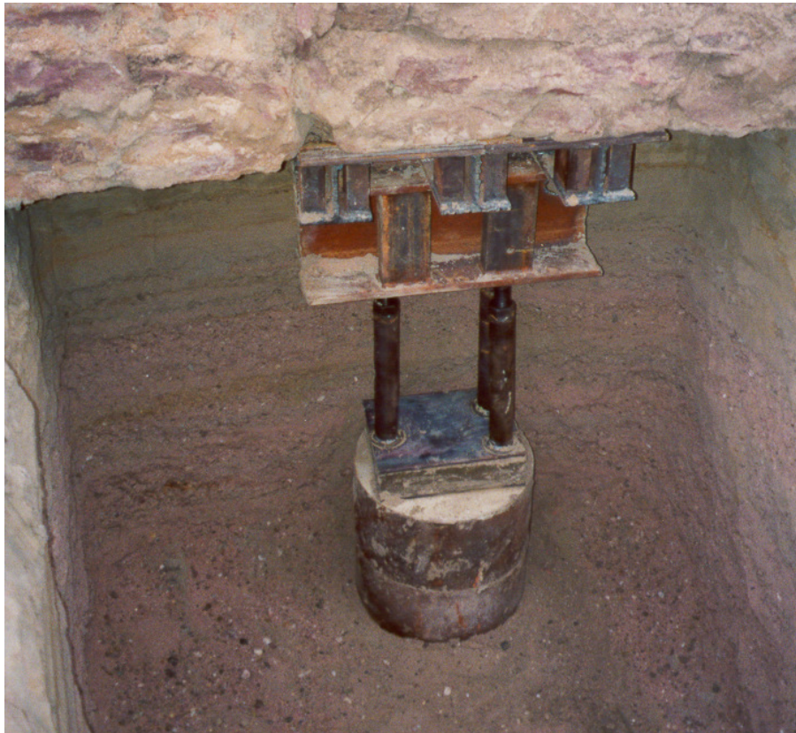
Abbildung 1: Pfahlkopfkonstruktion unter Fundament
