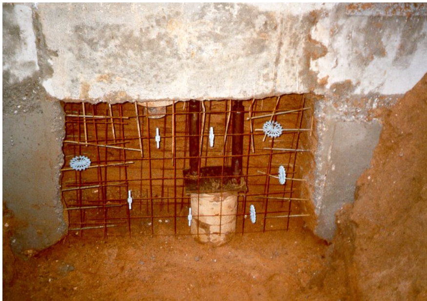
Abbildung 6: Bewehrter Abschnitt mit festgelegtem Pfahl
