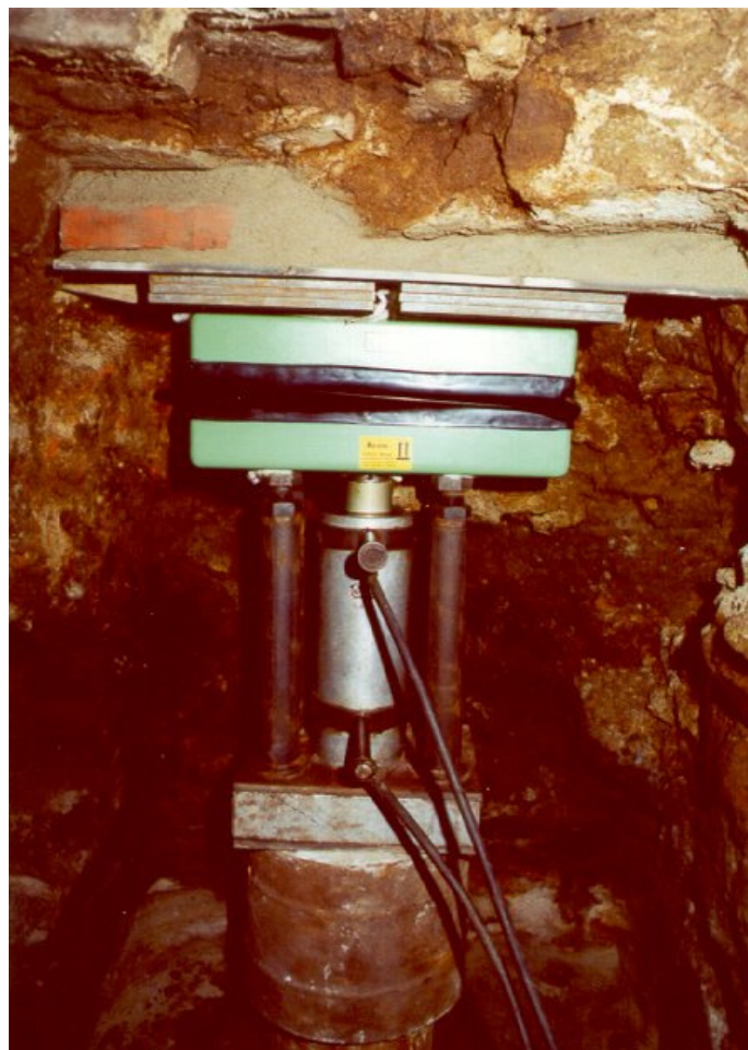
Abbildung 8: Segment-Presspfahl mit Schwingungsisolator
