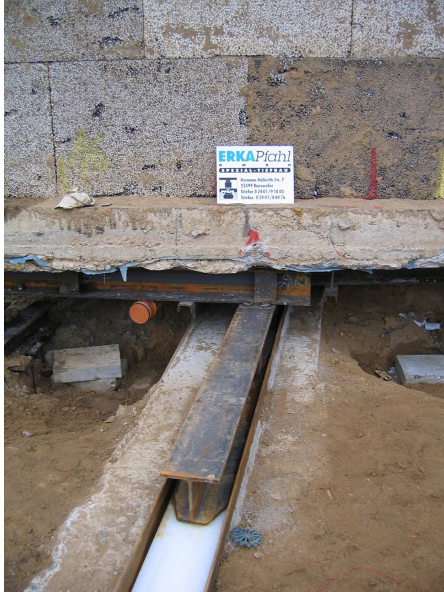
Bild 4 Einer der Verschiebeträger in seiner Gleitschiene
