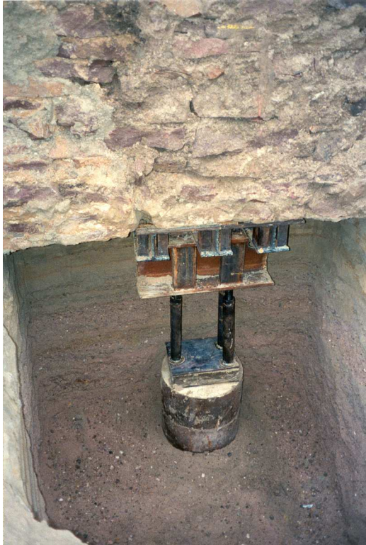
Bild 2 Das ERKA Pfahlsystem: Pfahlkopf eines eingebauten Segmentpfahls
