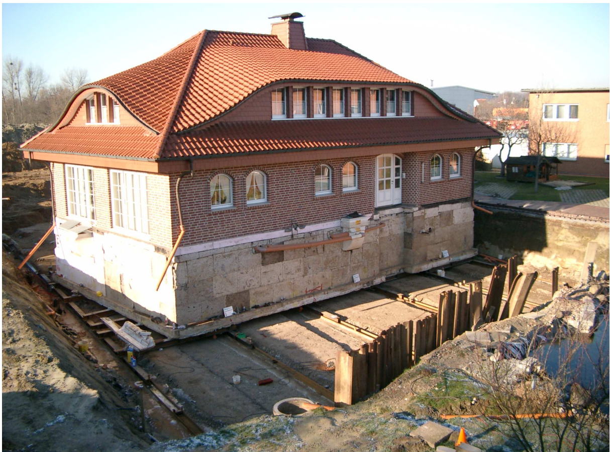
Bild 6 Nach einer Reise von ca. 30 Metern bewegt sich das Haus auf sein Ziel zu.
