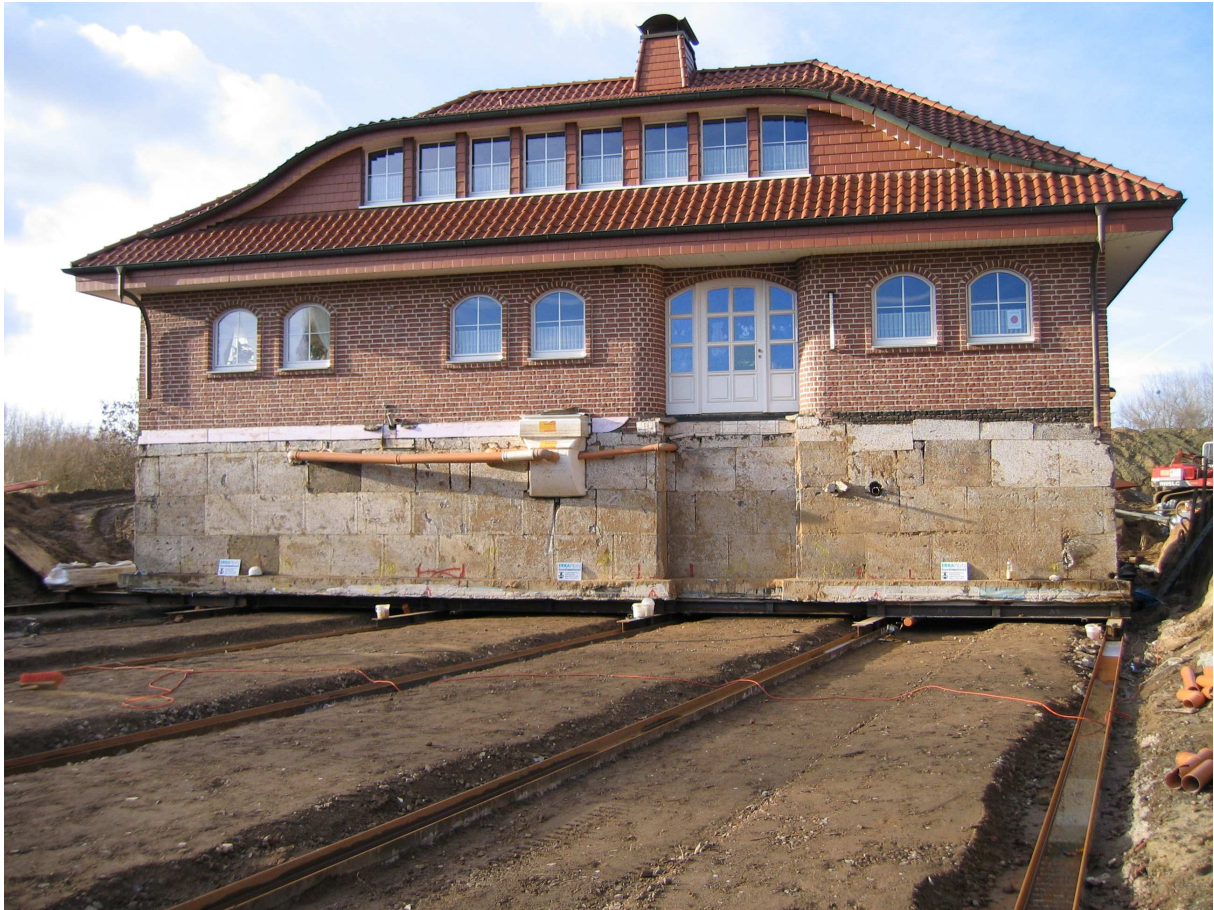
Bild 5 Ein Haus auf Schienen – die Verschiebeleistung betrug ca. 1 Meter pro Stunde
